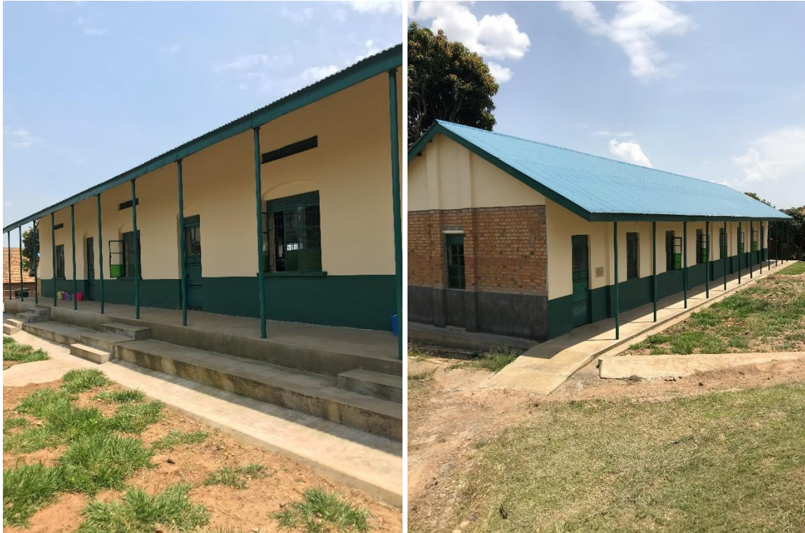
Fotos 1. Vista exterior de los dormitorios principal (izquierda) y secundario (derecha)
