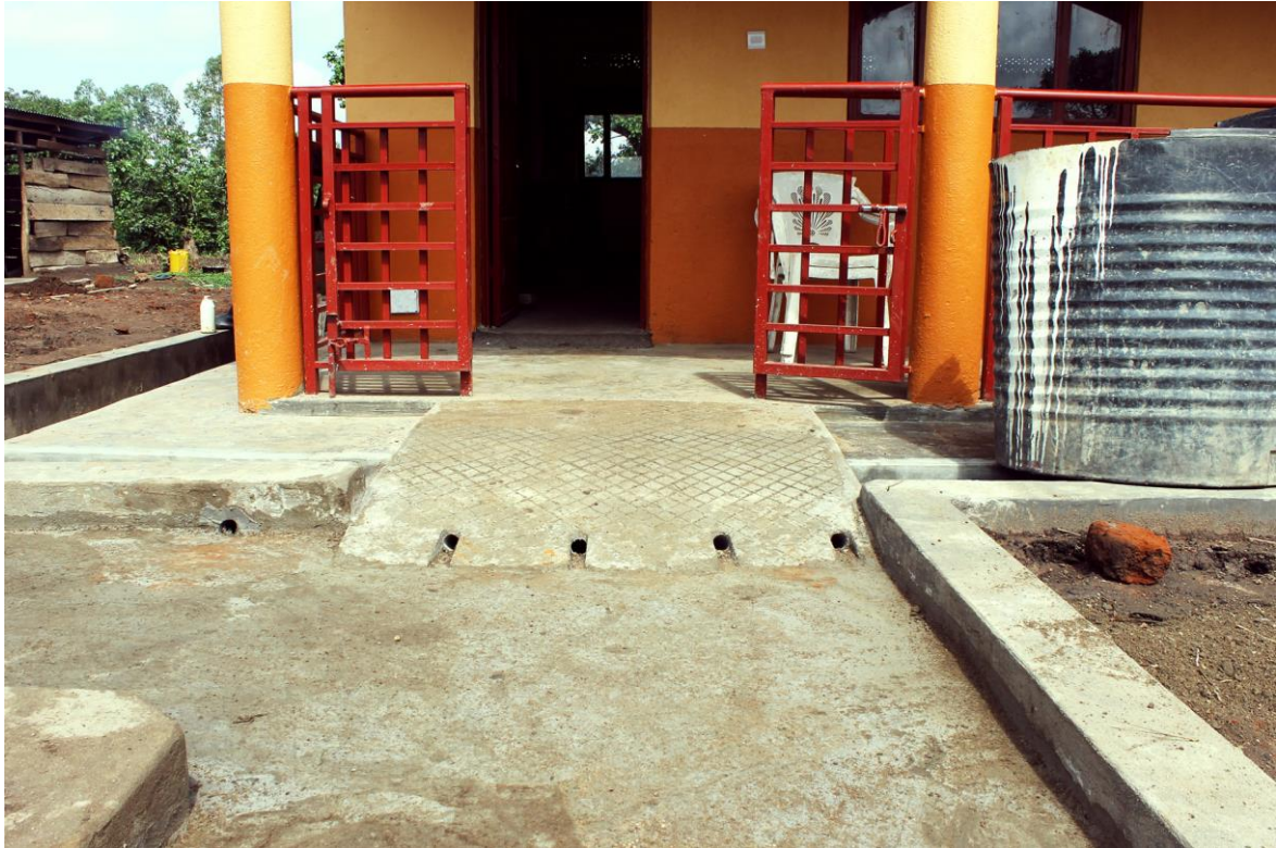
25 Finalización de exteriores.
