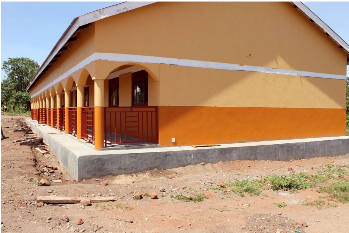
13 Trabajos de pintura
