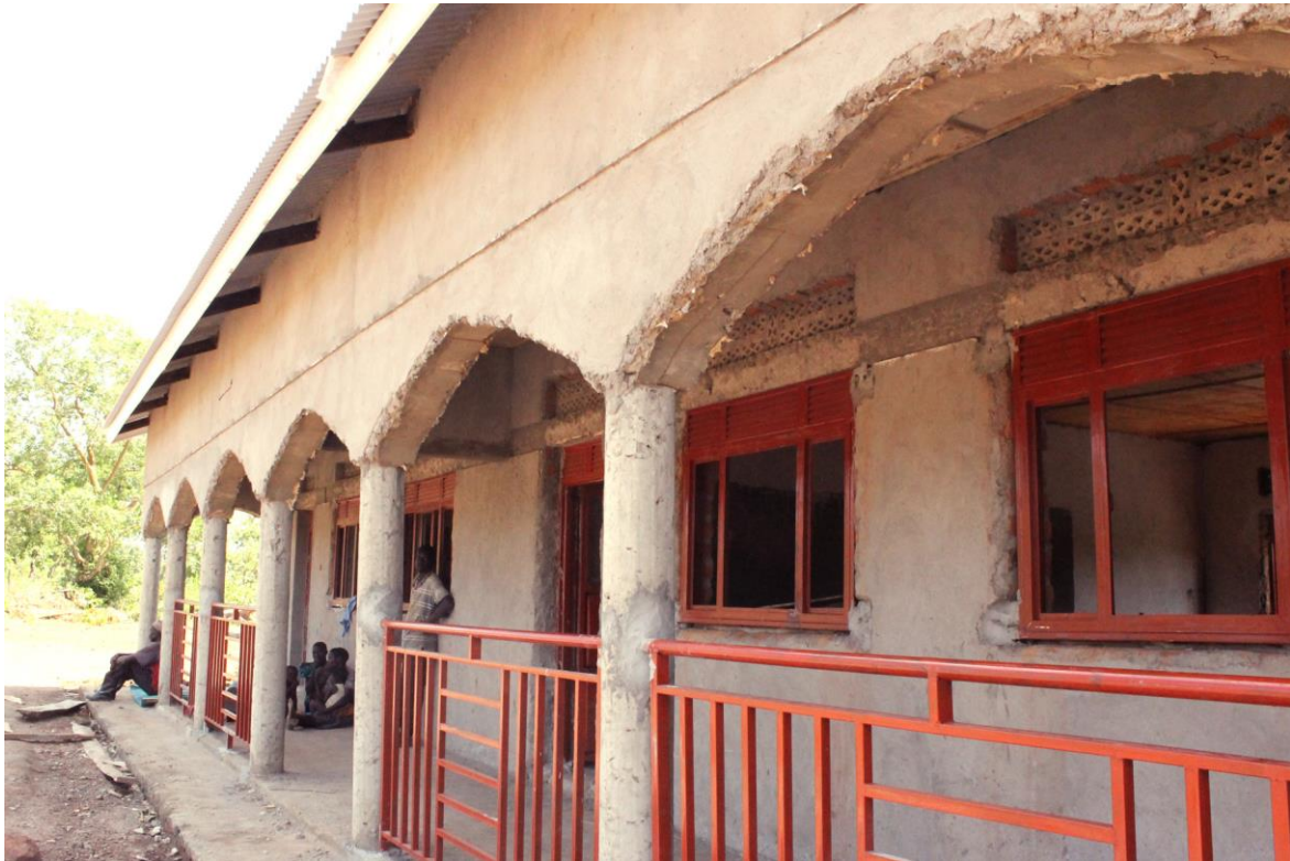
8 Trabajos de acabados exterior
