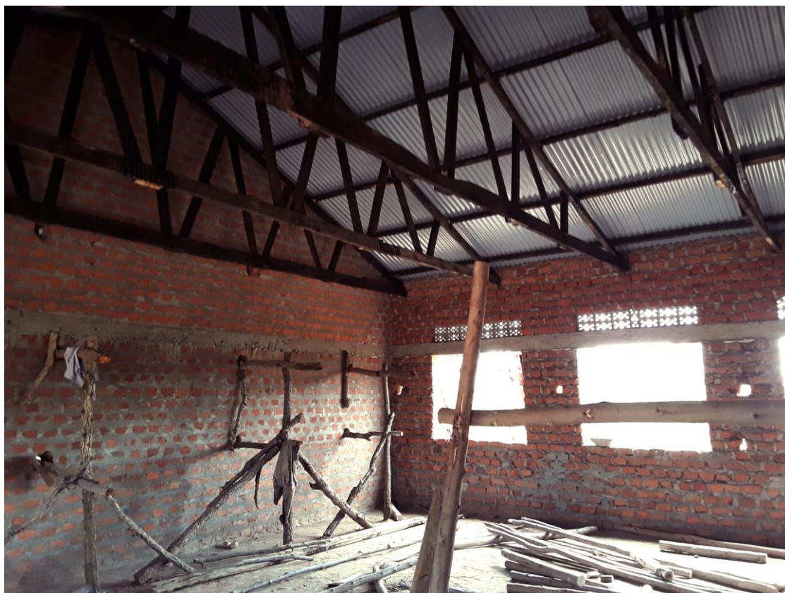
3 Trabajos en el tejado
