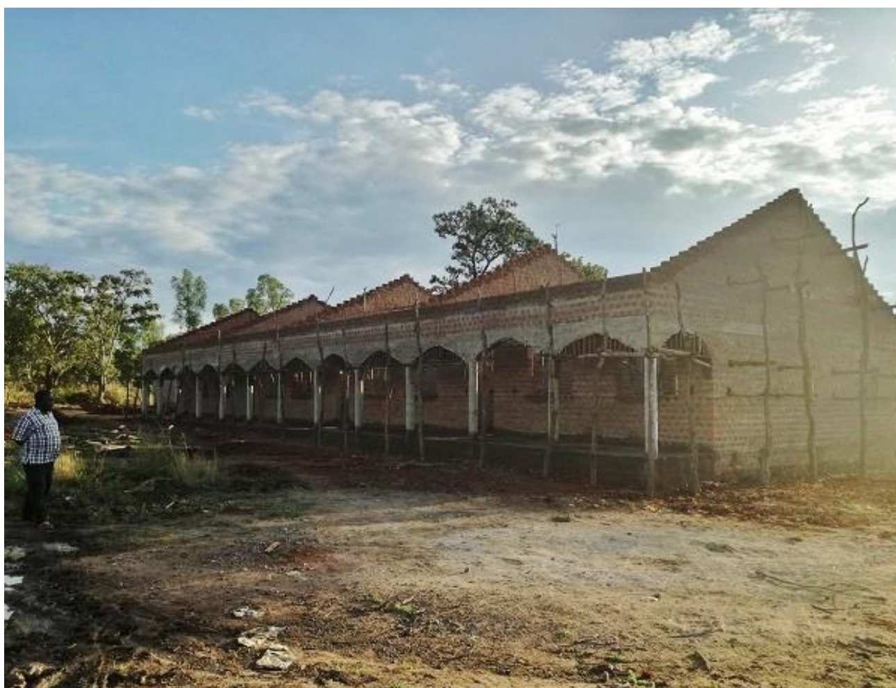
2 Construcción realizada por la contraparte local
