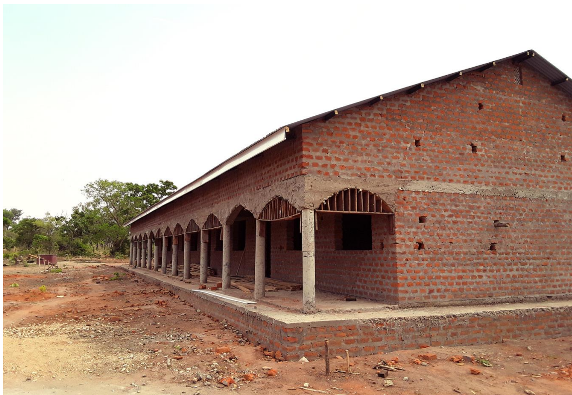
4 Obras de finalización del exterior
