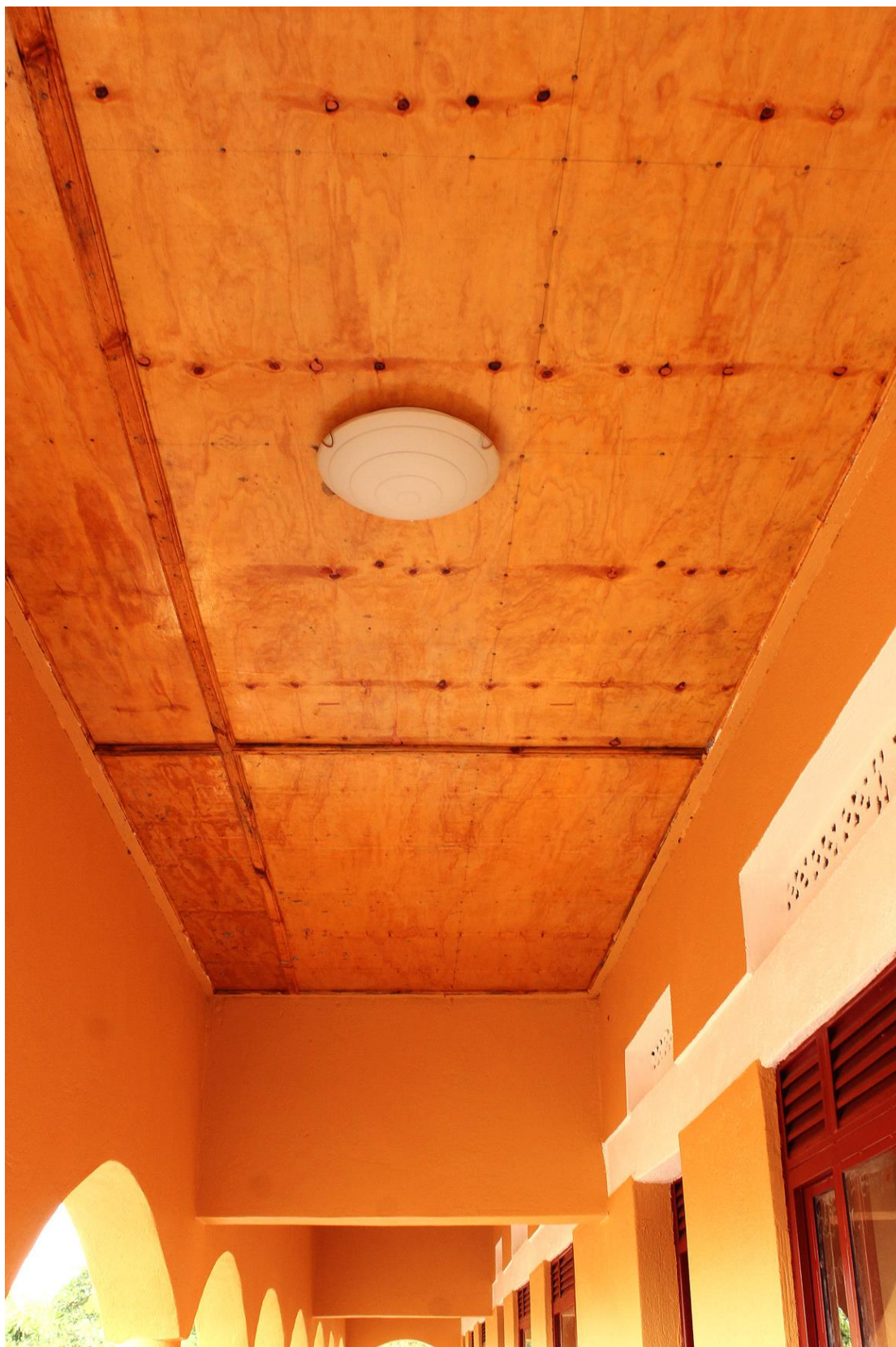
22 Finalización de la electrificación y exteriores.
