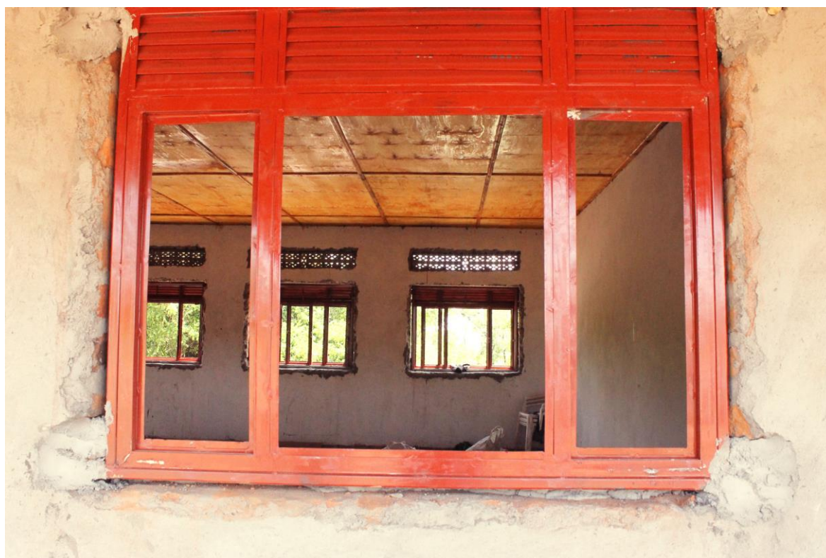
5 Instalación de ventanas
