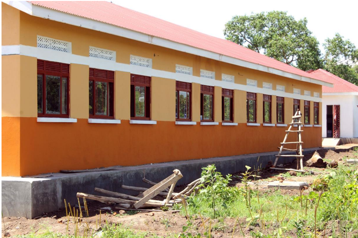
14 Acabados de pintura
