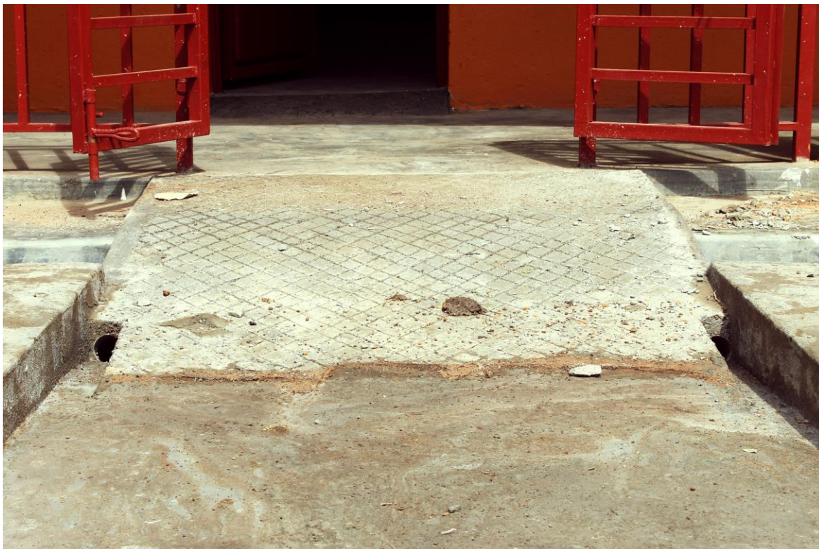
23 Finalización de exteriores.
