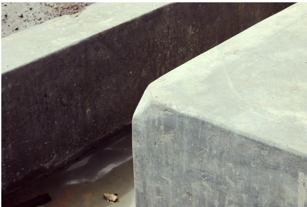
32 Finalización de las esquinas exteriores.
