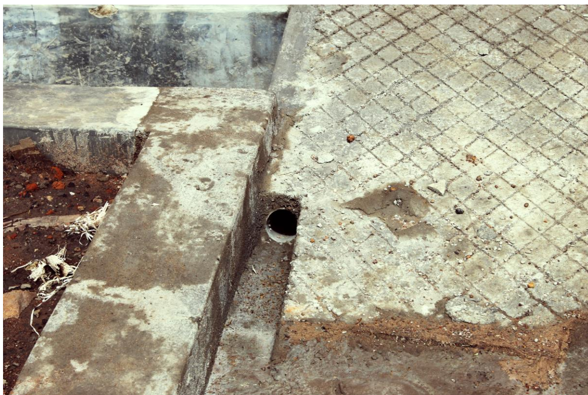
24 Finalización de exteriores.
