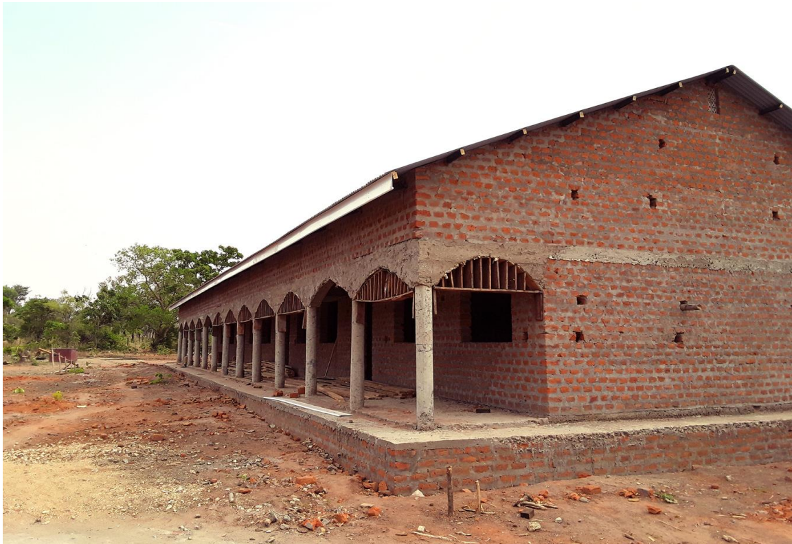
4 Obras de finalización del exterior
