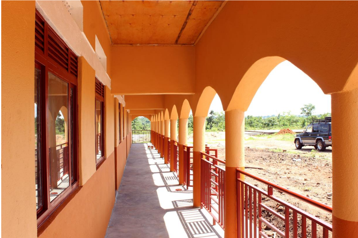
12 Acabados de la baranda
