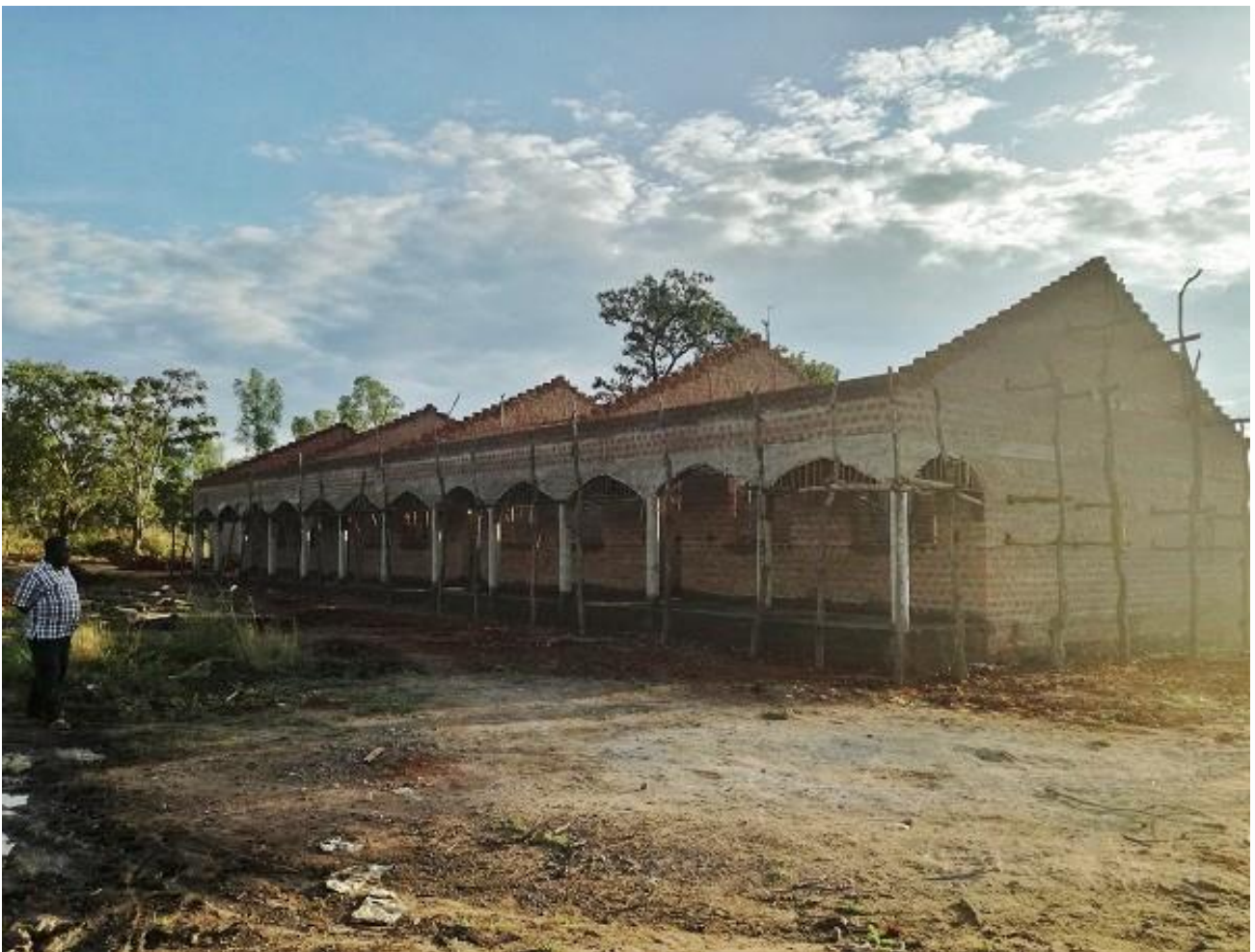
2 Construcción realizada por la contraparte local
