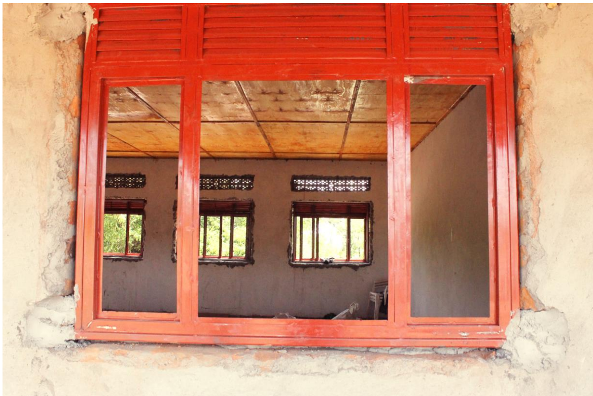
5 Instalación de ventanas
