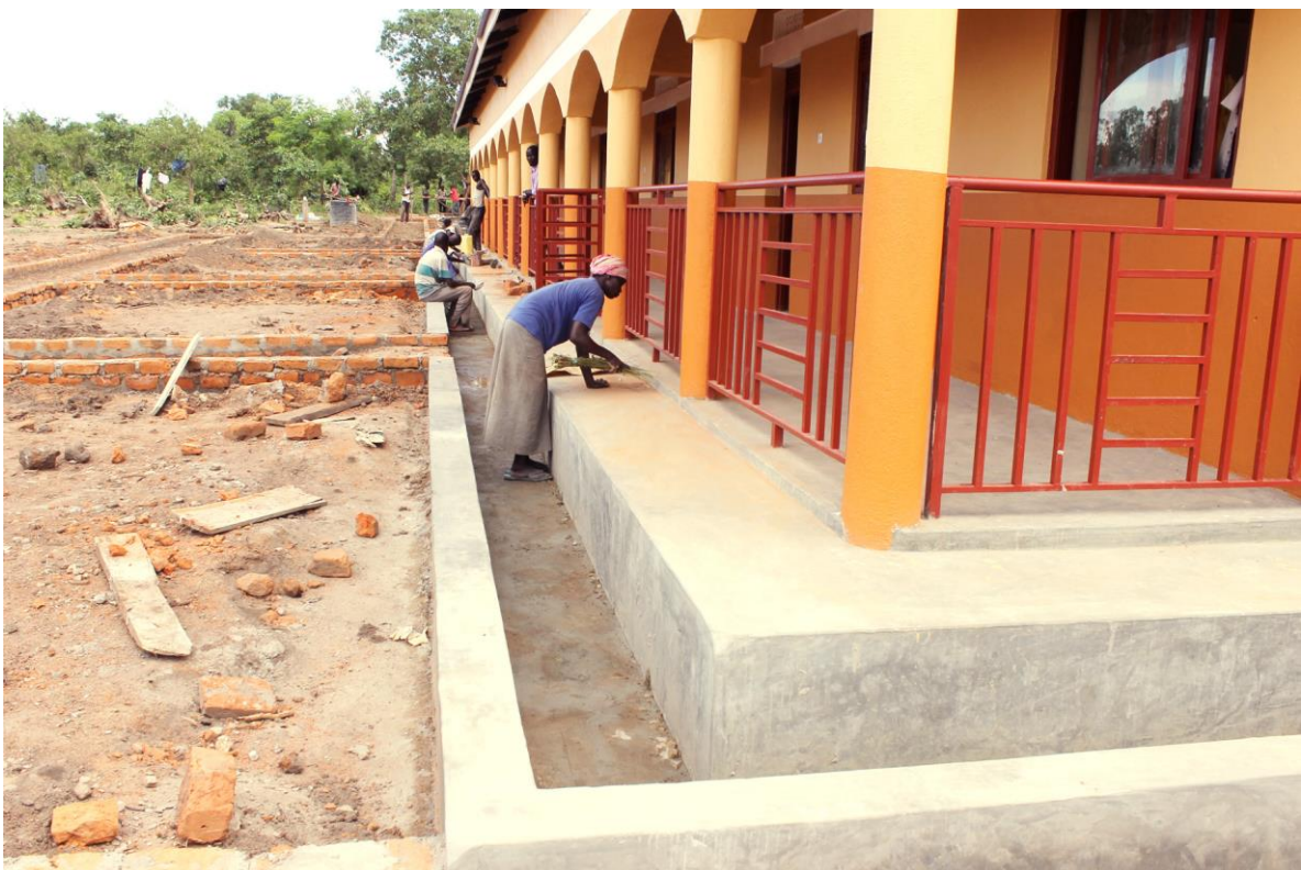
11 Trabajos de la mejora y canalización de aguas
