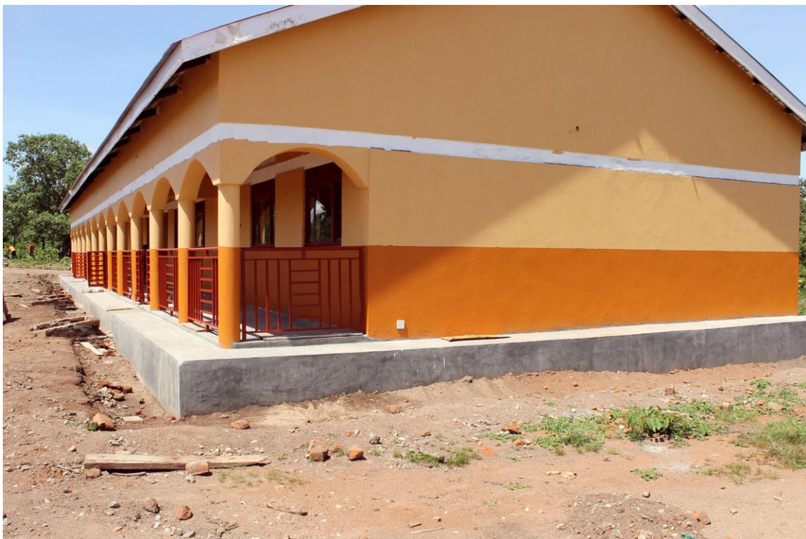
13 Trabajos de pintura
