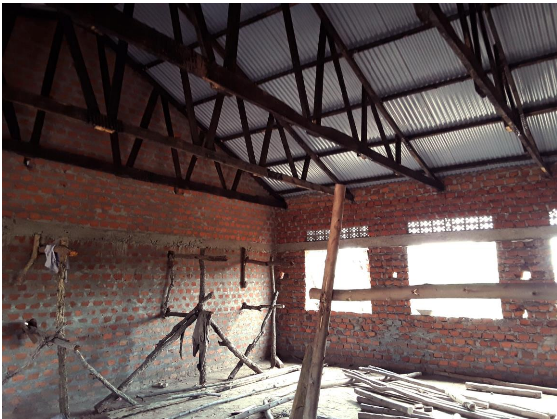
3 Trabajos en el tejado
