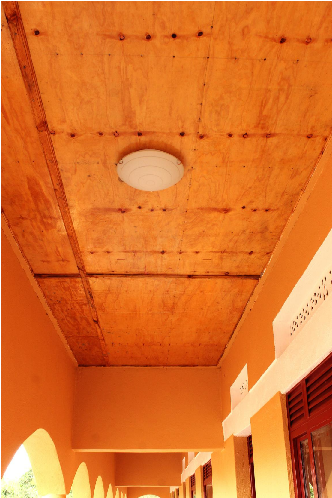
22 Finalización de la electrificación y exteriores.
