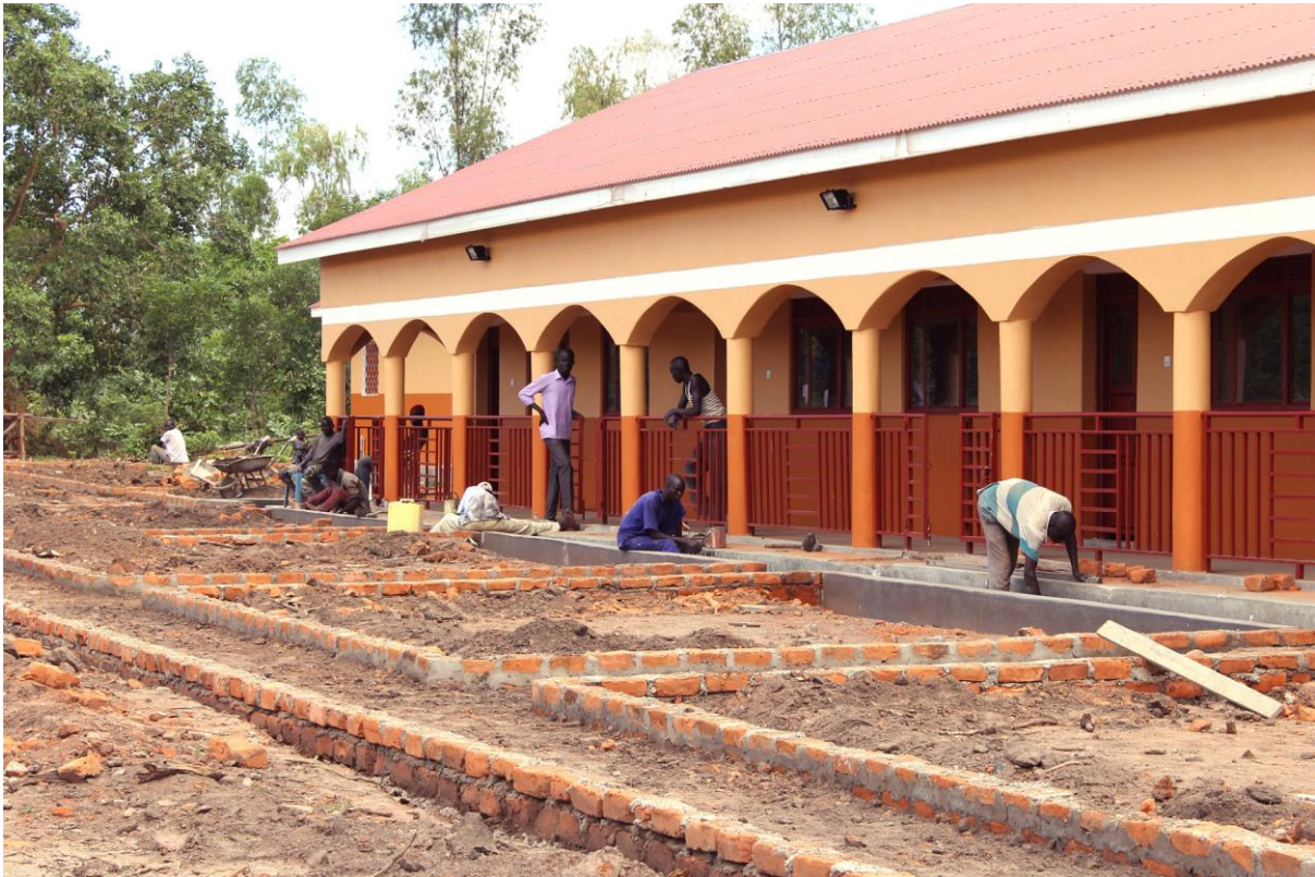
16 Mejoras del exterior, pasillo que conecta todas las aulas con los baños para niños en silla de rueda
