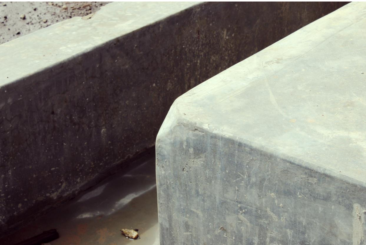
32 Finalización de las esquinas exteriores.
