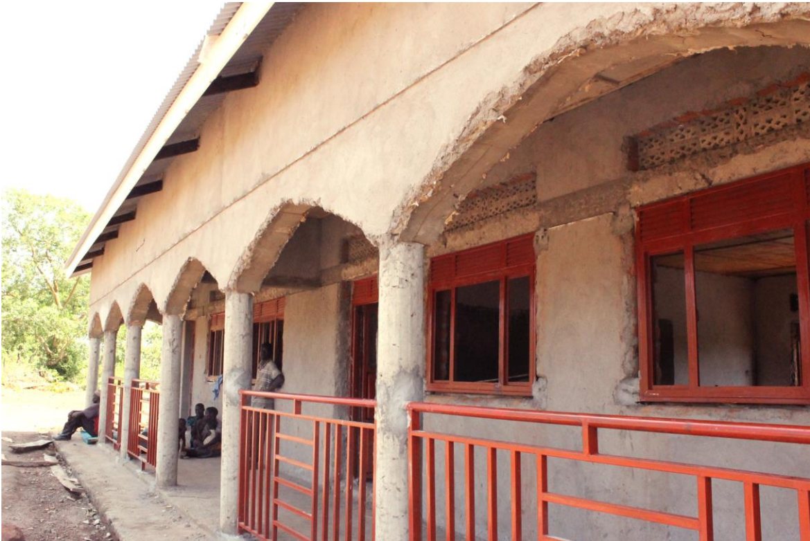
8 Trabajos de acabados exterior
