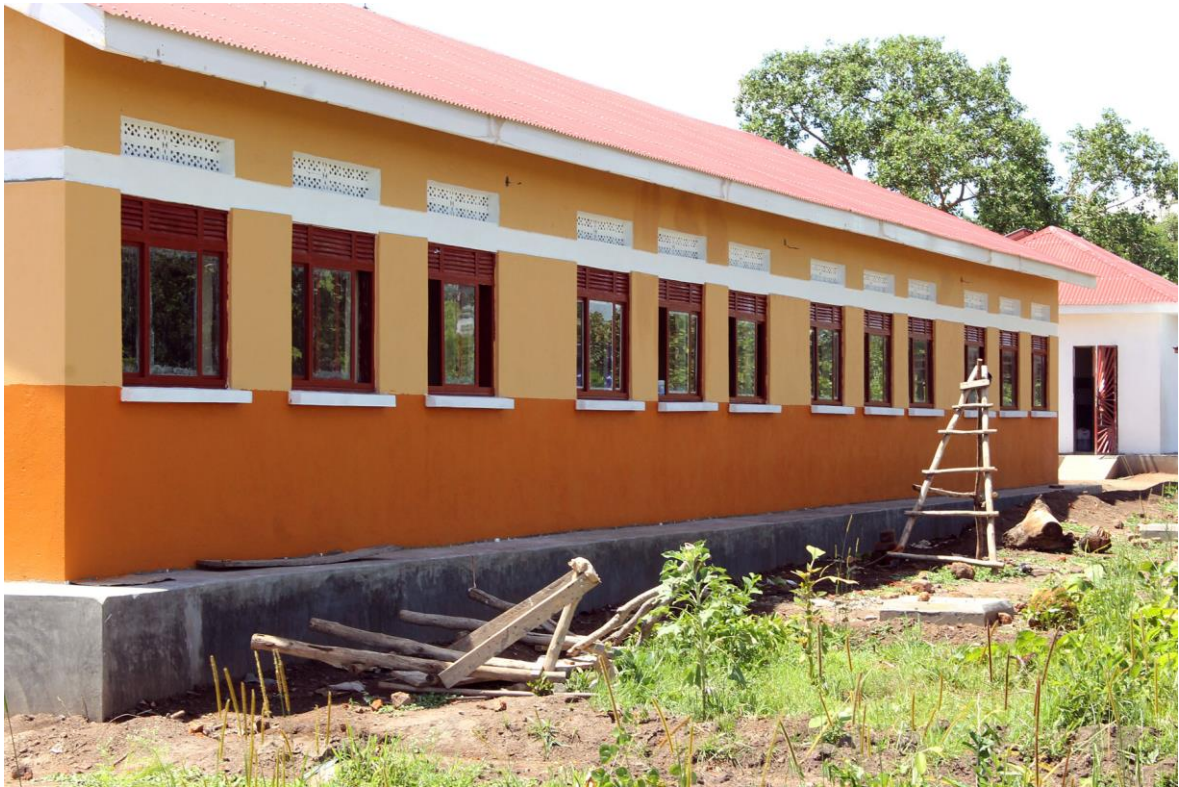
14 Acabados de pintura
