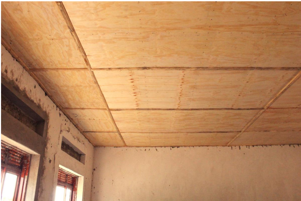
7 Acabados interior y falso techo
