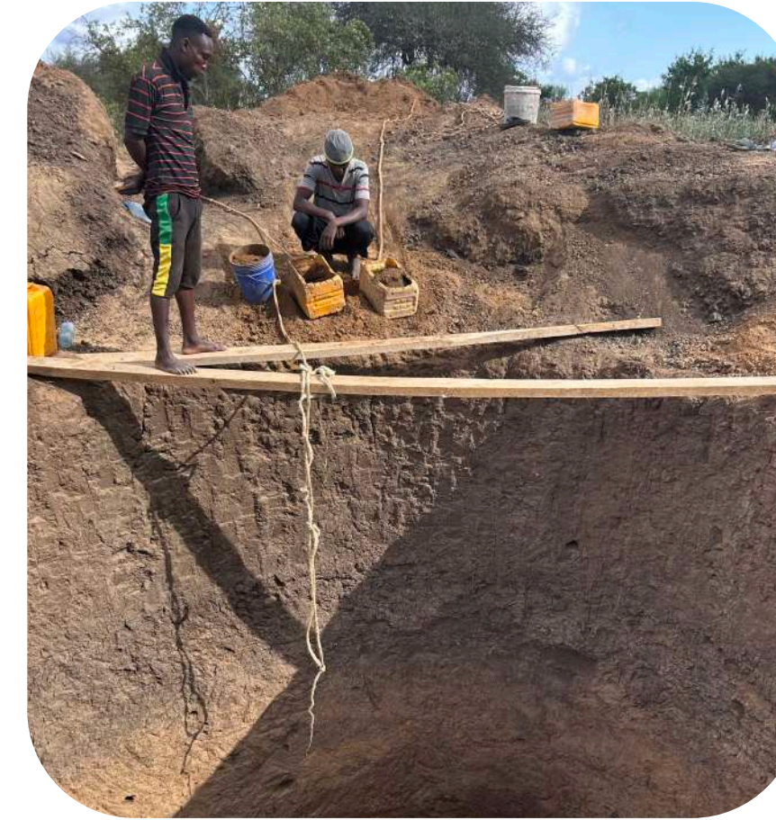
Proceso de instalación de la fosa séptica.
