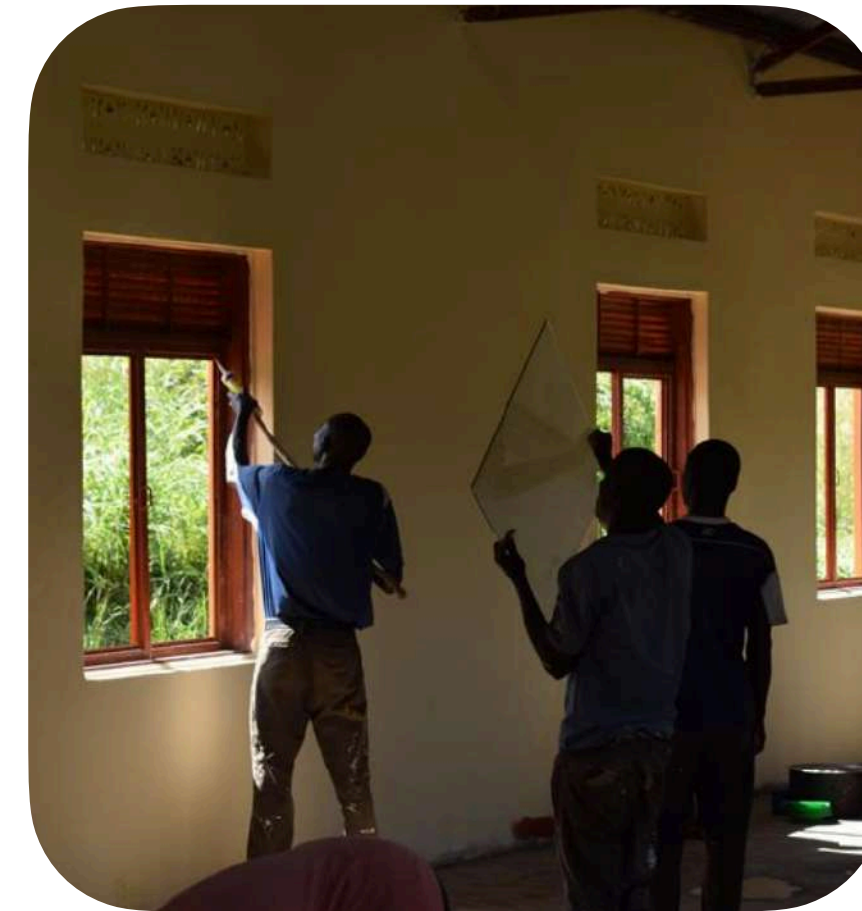
Instalación de las ventanas en una de las dos aulas.
