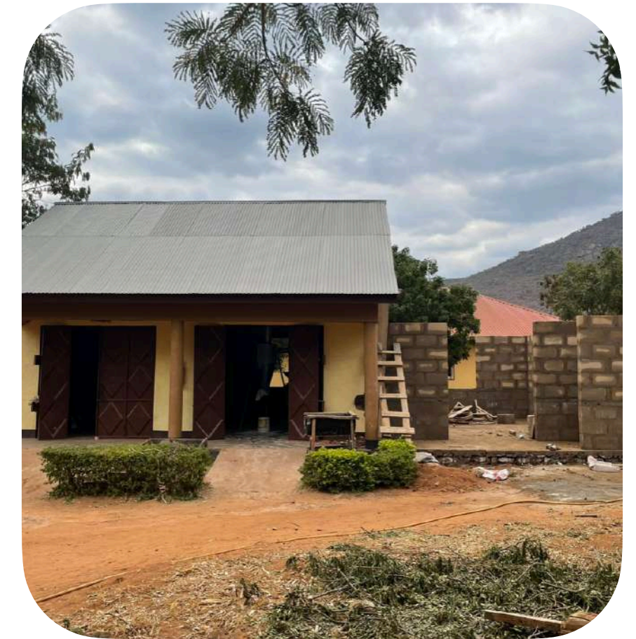
Proceso de construcción de la habitación, junto con la estructura que alberga el molino de maíz.
