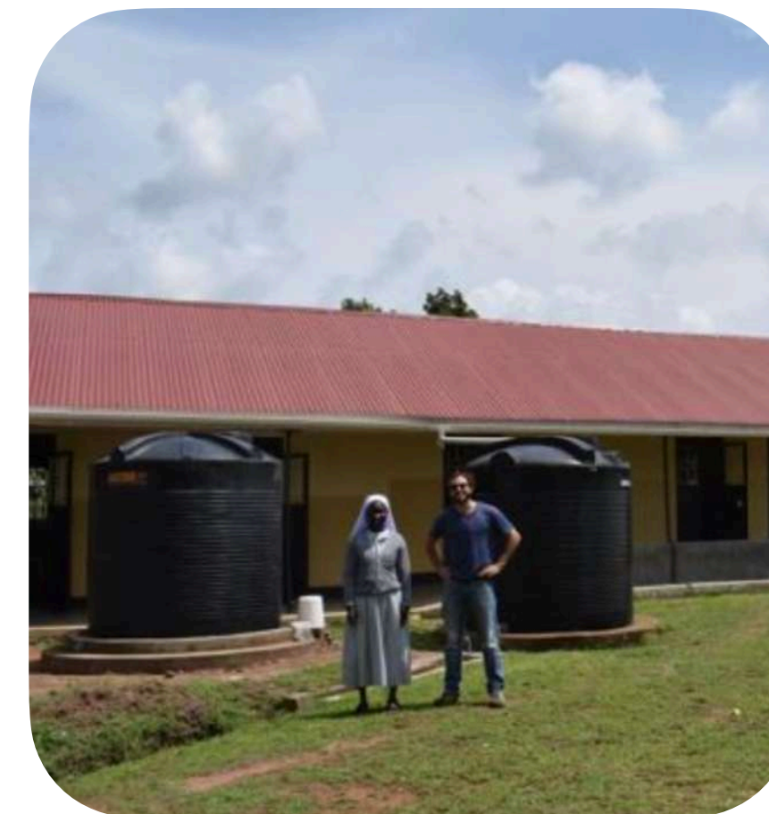
Instalación Tanques de Agua Health Center III (Oje, Uganda).
