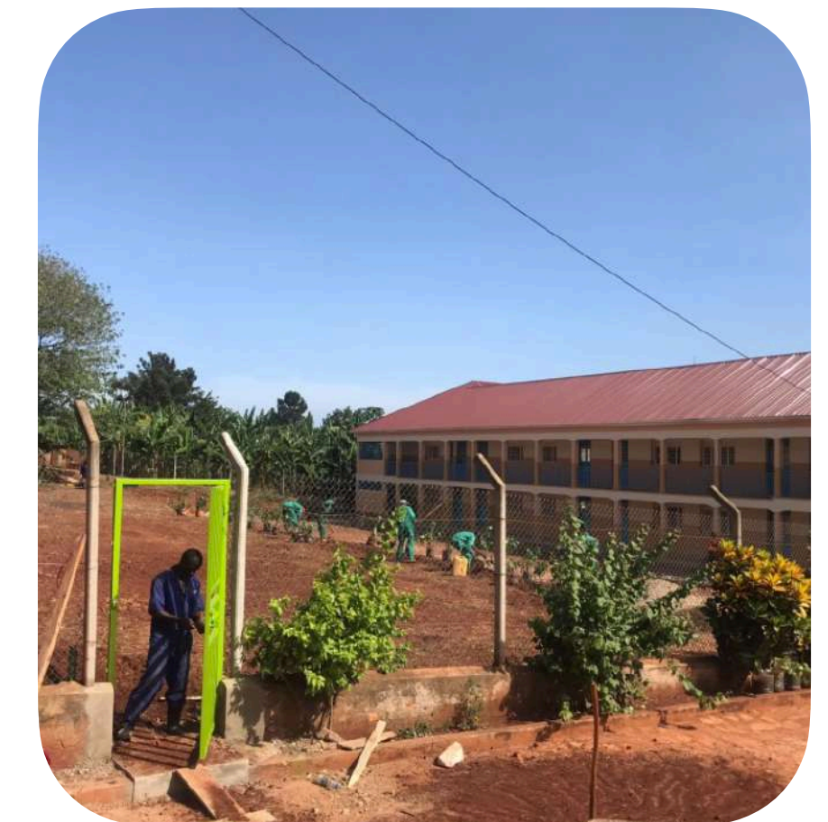
Adecuación de terrenos anexos al nuevo edificio Social y Educativo.
