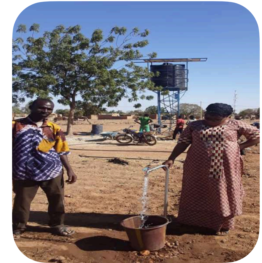
Pozo e Instalación de Bomba y Tanque (Malou, Burkina Faso).
