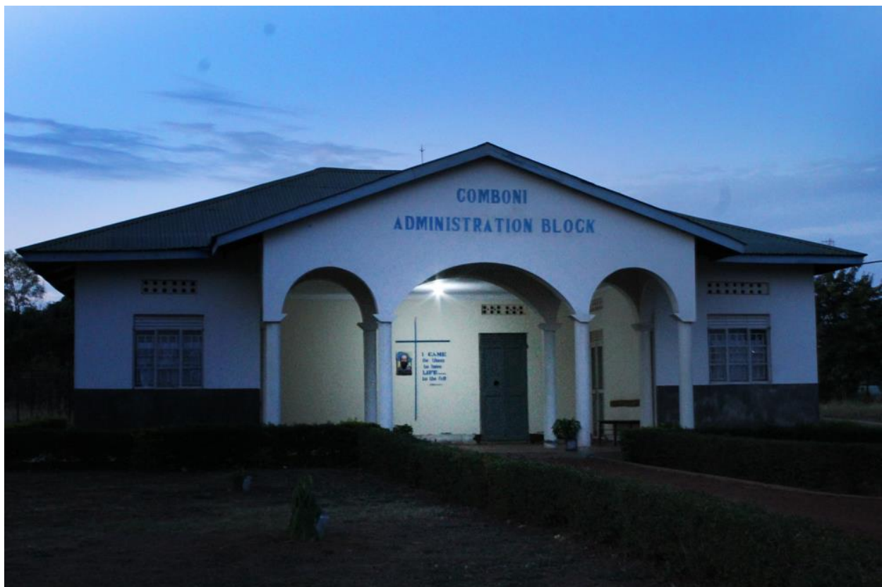
7 Detalle de iluminación exterior del bloque de administración
