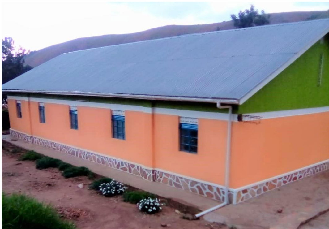
Imagen 01. Vista posterior del edificio con nuevo revestimiento.
