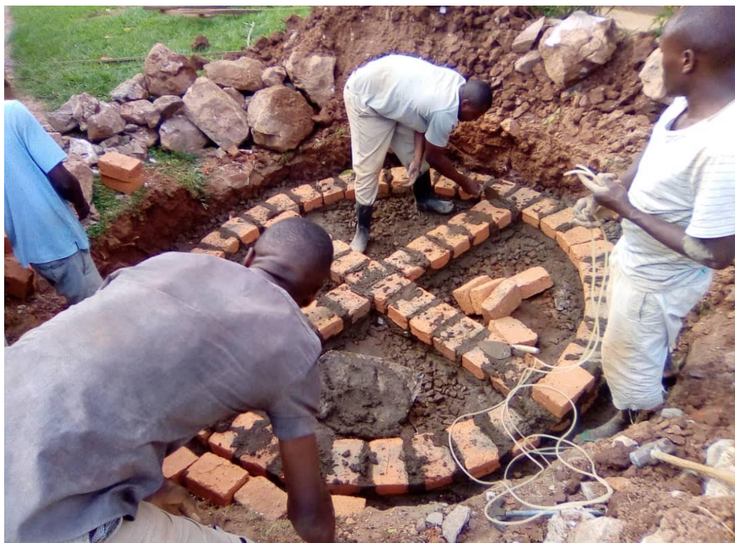
Imagen 10. Construcción de nuevo pozo para aguas residuales.
