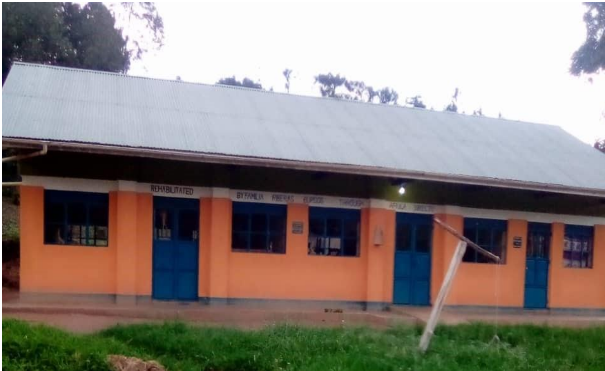
Imagen 07. Foto de la entrada del edificio terminado con la pintura antihumedad.
