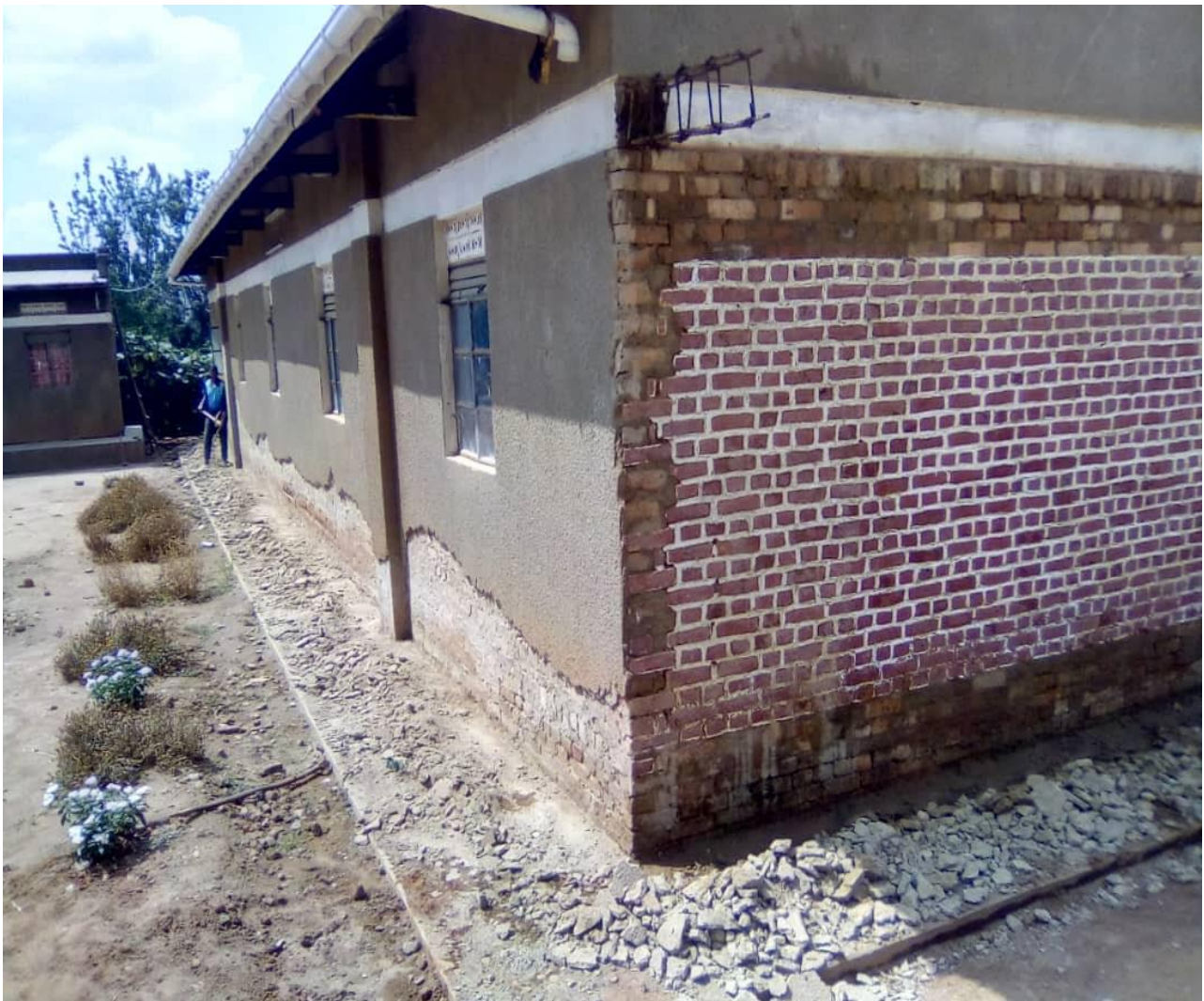
Imagen 02. Retirada del revestimiento antiguo dañado por el agua.
