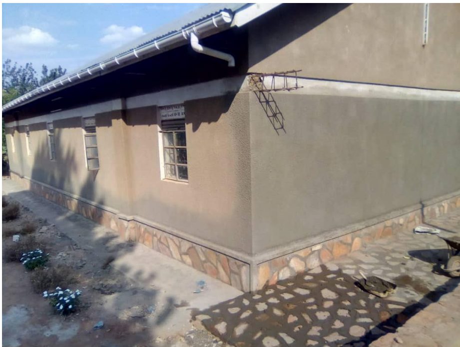
Imagen 04. Nuevo revestimiento y nueva baranda lateral.
