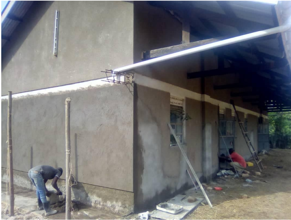
Imagen 03. Reparación del revestimiento principal y lateral del edificio.
