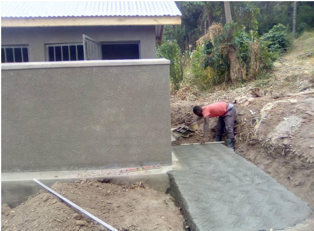
Imagen 12. Rampa de acceso para los aseos.
