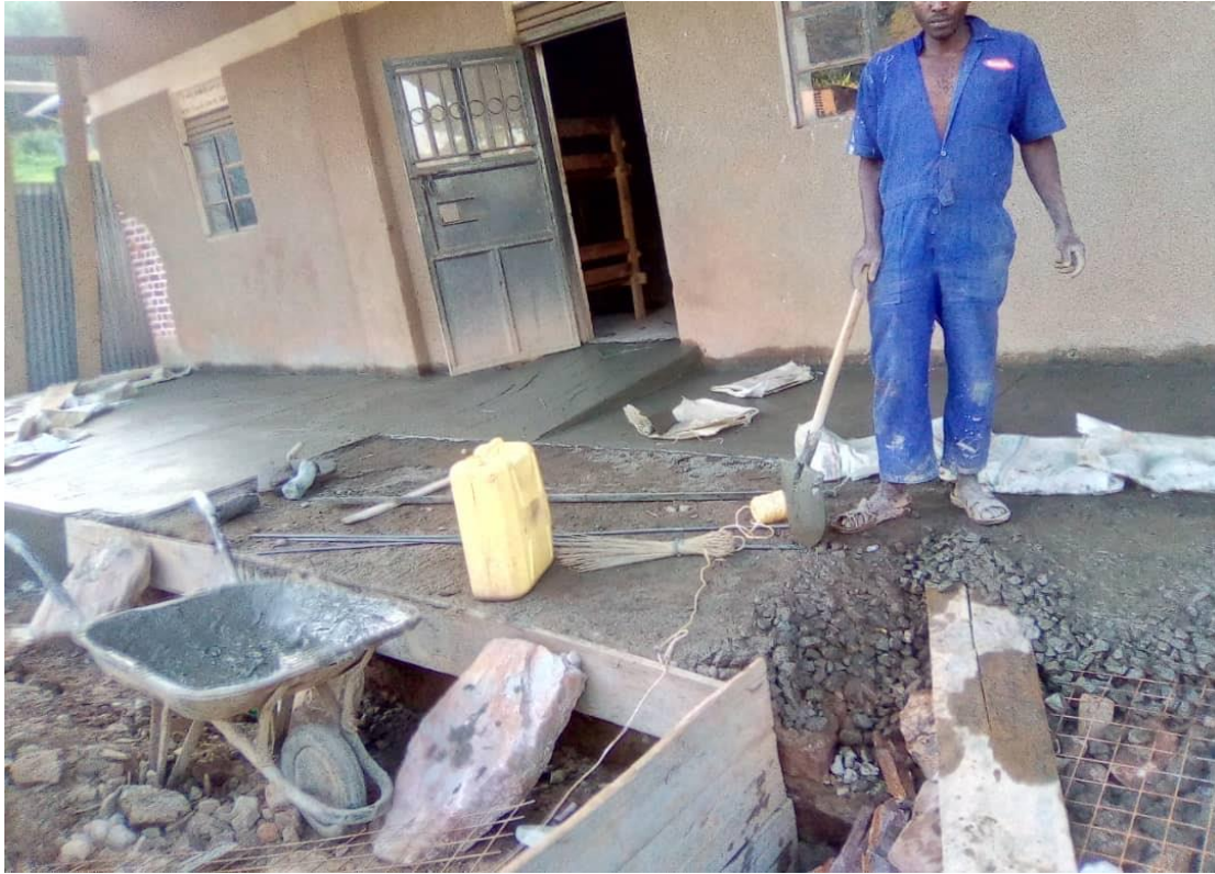
Imagen 05. Reparación y ensanche de la baranda de la entrada principal del edificio.
