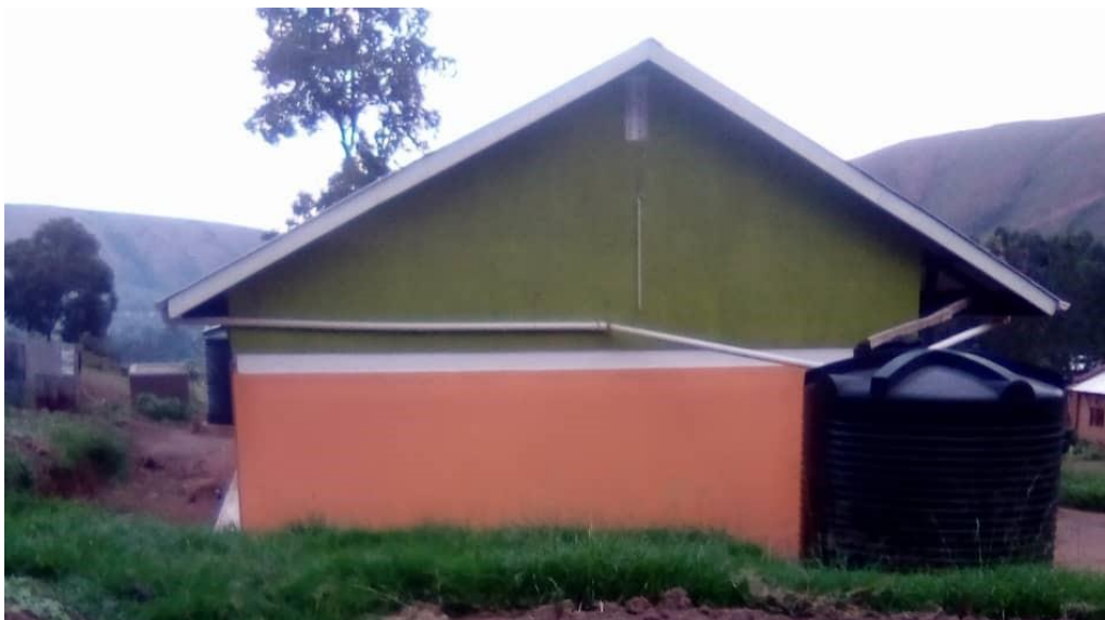
Imagen 08. Foto lateral del tanque de agua y recogida de agua.
