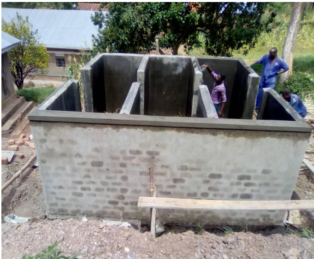
Imagen 13. Construcción de las nuevas duchas para las chicas.
