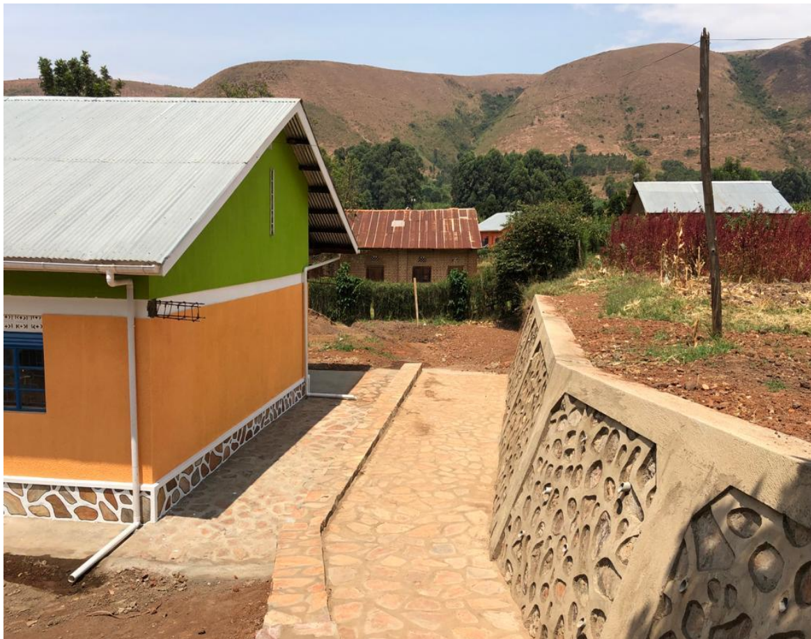
Imagen 09. Foto lateral y posterior del edificio con el muro de contención.
