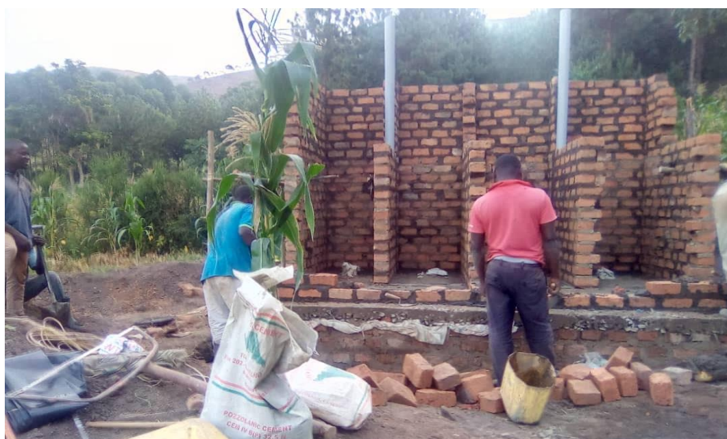
Imagen 11. Construcción de los nuevos aseos para las chicas.
