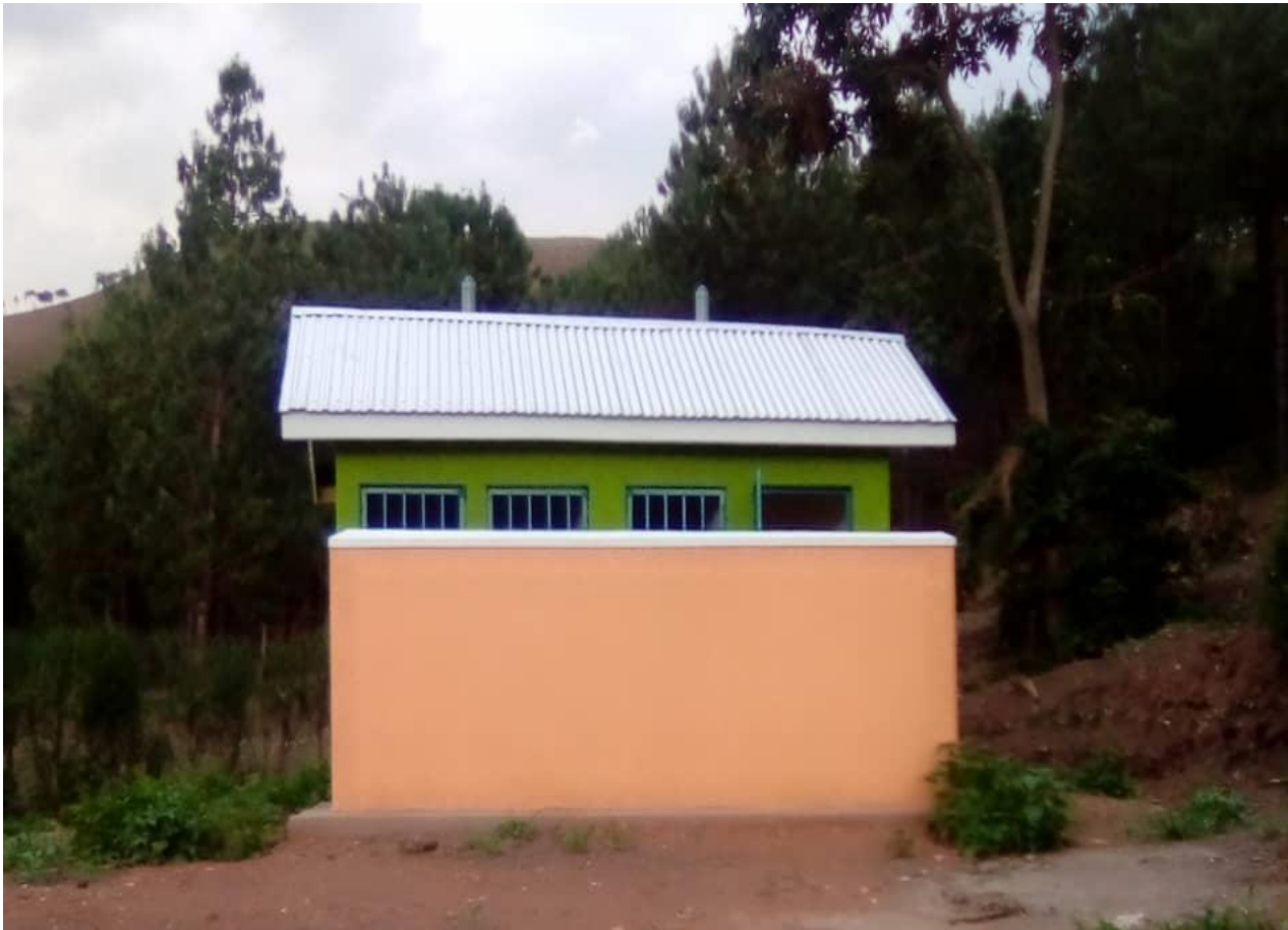
Imagen 14. Foto acabada de los aseos.
