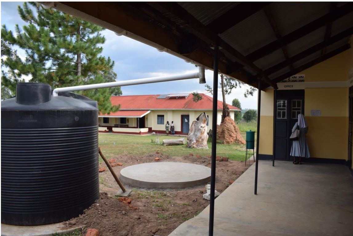
5. Sister Salome entrando en la oficina, al lado de la instalación del nuevo tanque de agua en la OPD.
