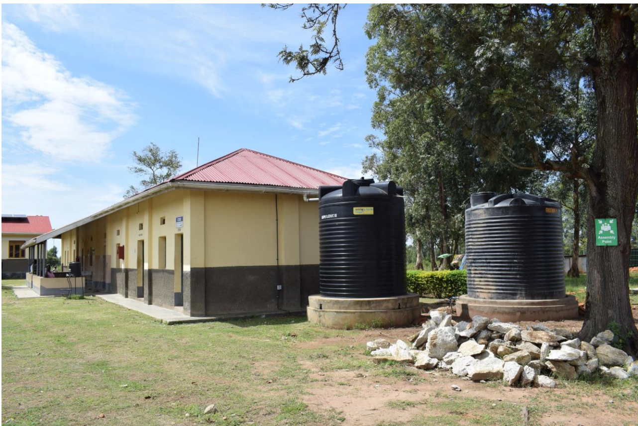
1. Uno de los tanques de agua frente al edificio de la Farmacia y el IPD del Health Center III de Oje.
