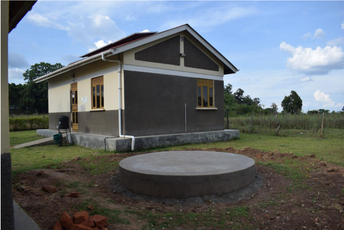
4. Plataforma sobre la que descansa el tanque de agua del Laboratorio y la Antigua OPD.
