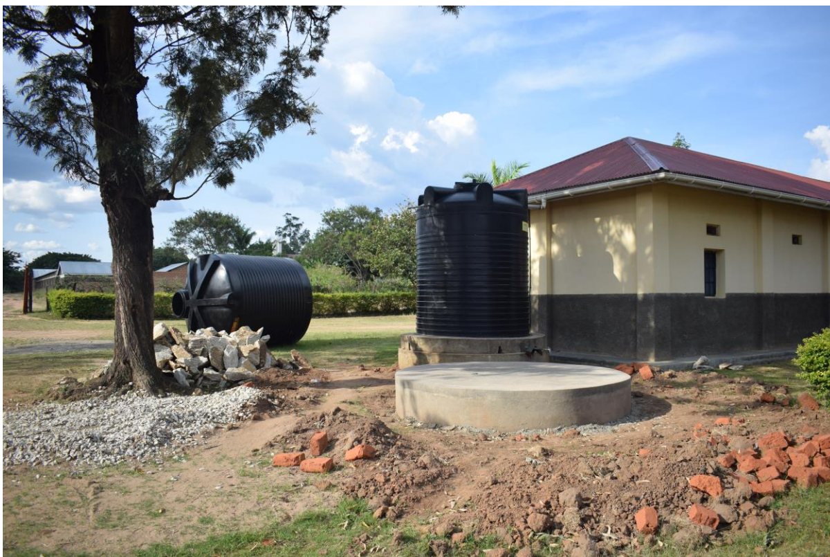
3. Detalle de la instalación de los tanques de agua.
