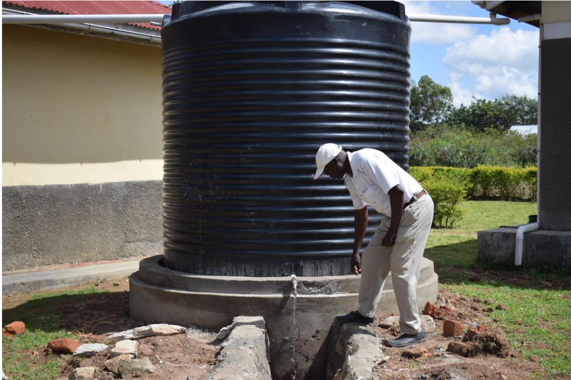
7. Francis, el constructor, comprobando el buen funcionamiento de los tanques de agua.
