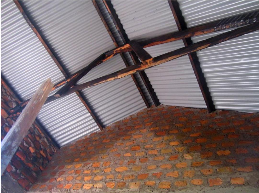
12 Instalación de las planchas de metal sobre la estructura para formar el tejado.
