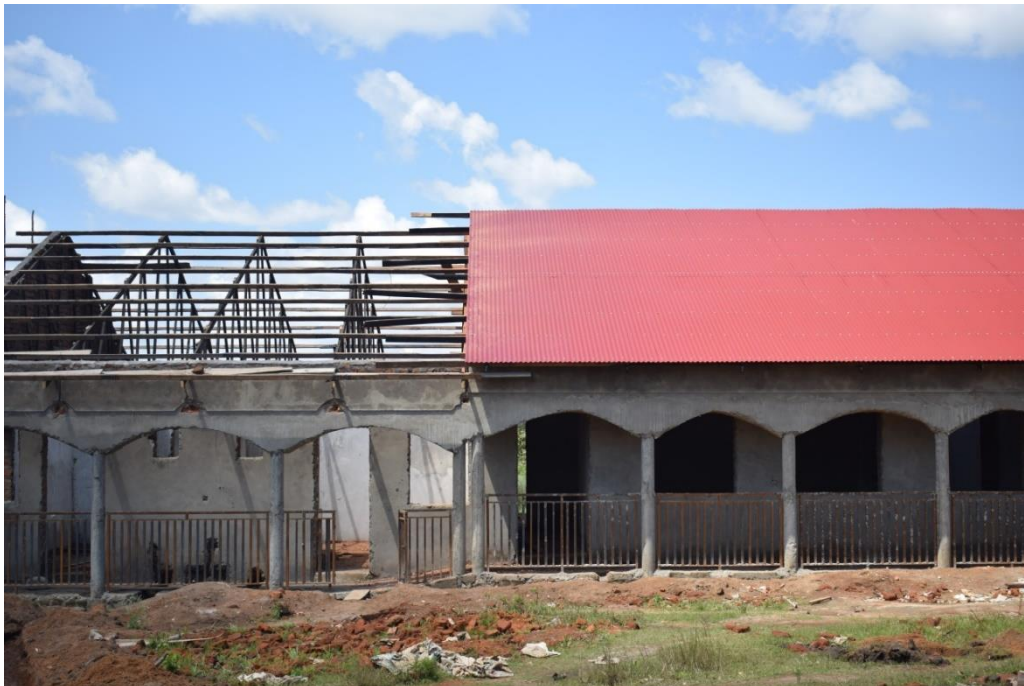
2. Progreso en la construcción del Edificio.
