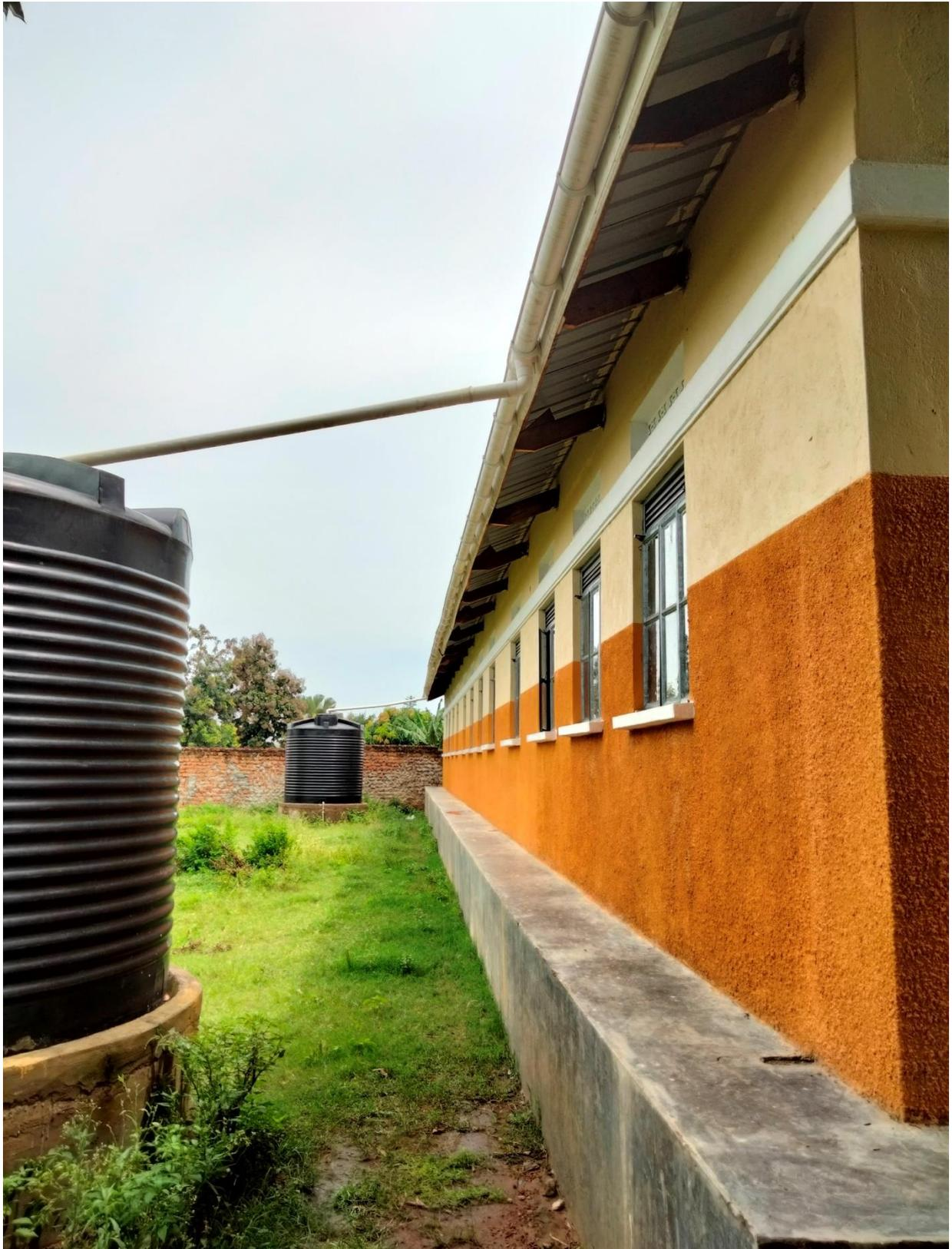
4. Fotografía de los dos tanques de agua y el sistema de calanización
