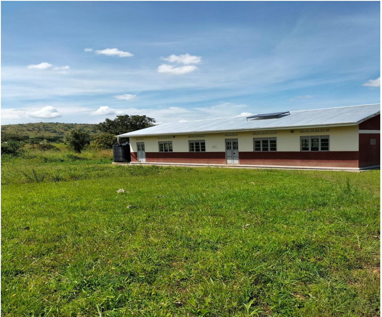
1. Bloque de clases de la escuela con el nuevo sistema de canalización y el tanque de agua al final
