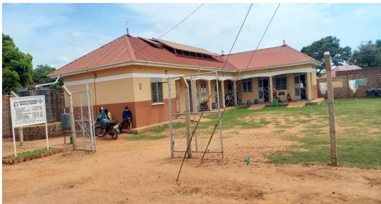
5. Fotografía del nuevo Health Center de Yumbe
