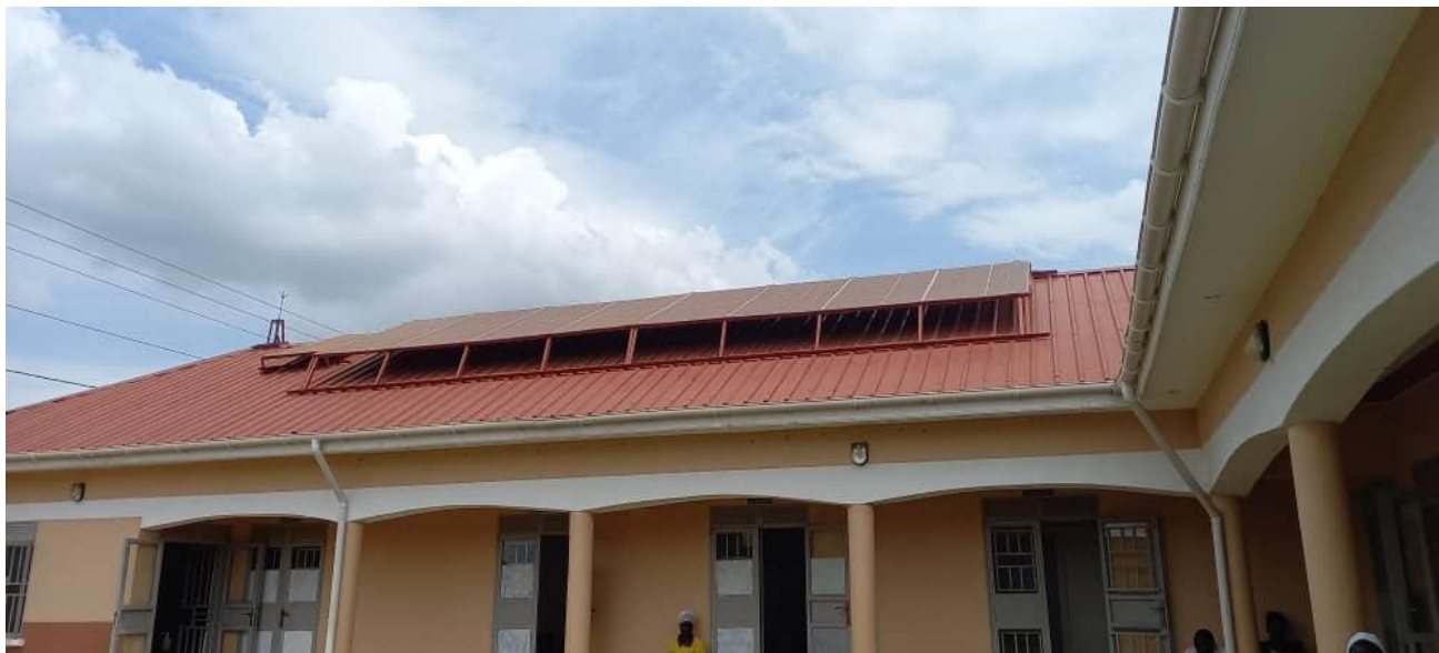
4. Placas solares en el nuevo Health Center de Yumbe
