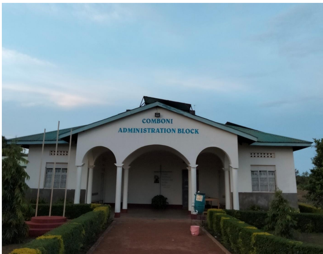
1. Bloque de Administración del Health Center IV, Lodonga
