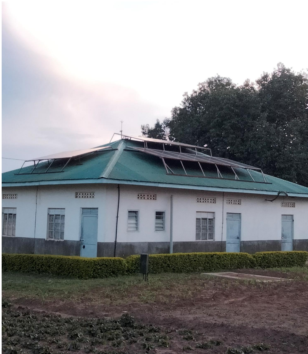
2. Fotografía de las nuevas placas solares instaladas por ITAL Trade
