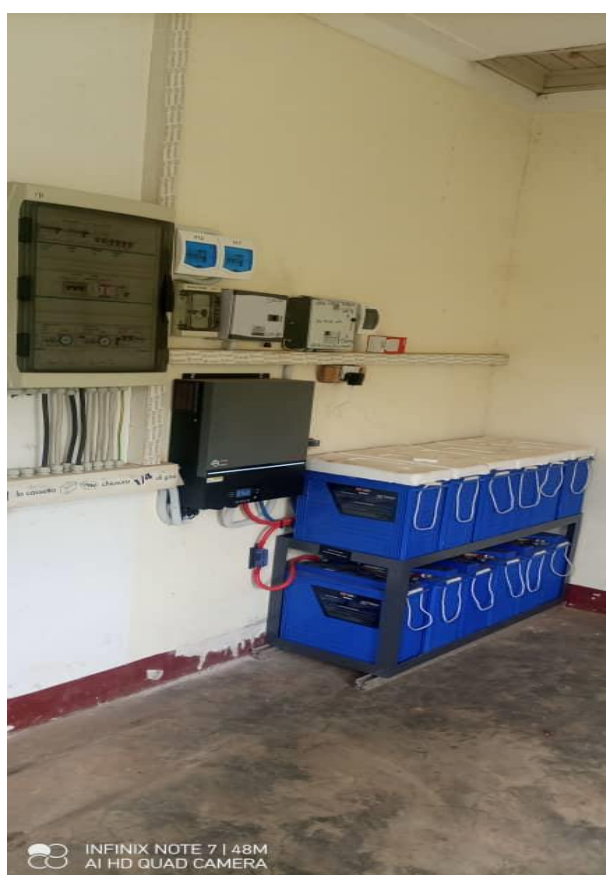
4. Baterías, inversor y panel eléctrico instalado en el HC IV de Lodonga
