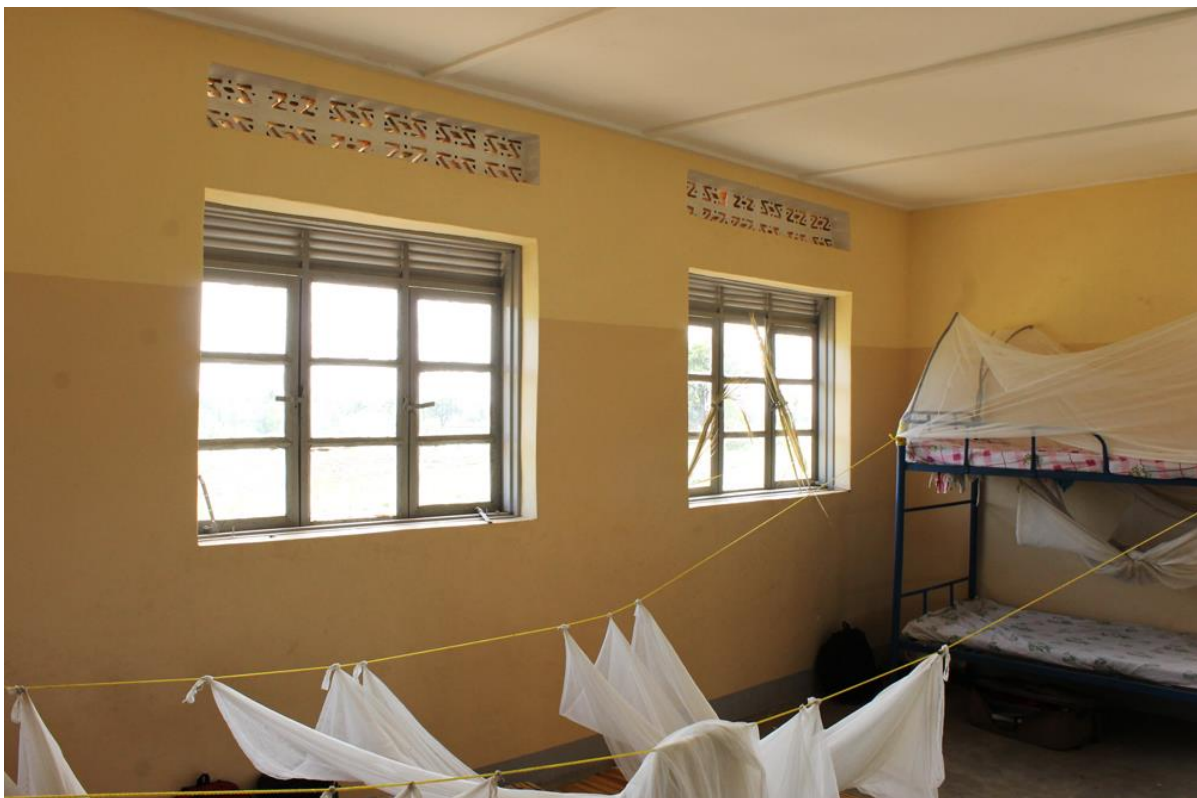
15. Detalle de las ventanas del dormitorio.
