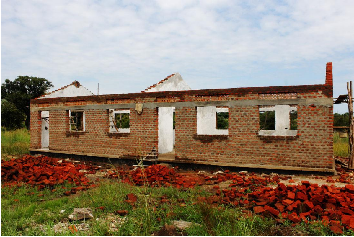
12. Superestructura terminada, parte exterior del edificio.
