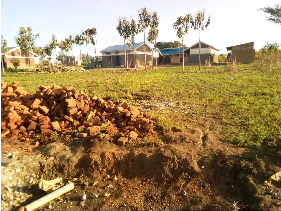
6. Preliminares, primera excavación de los cimientos.
