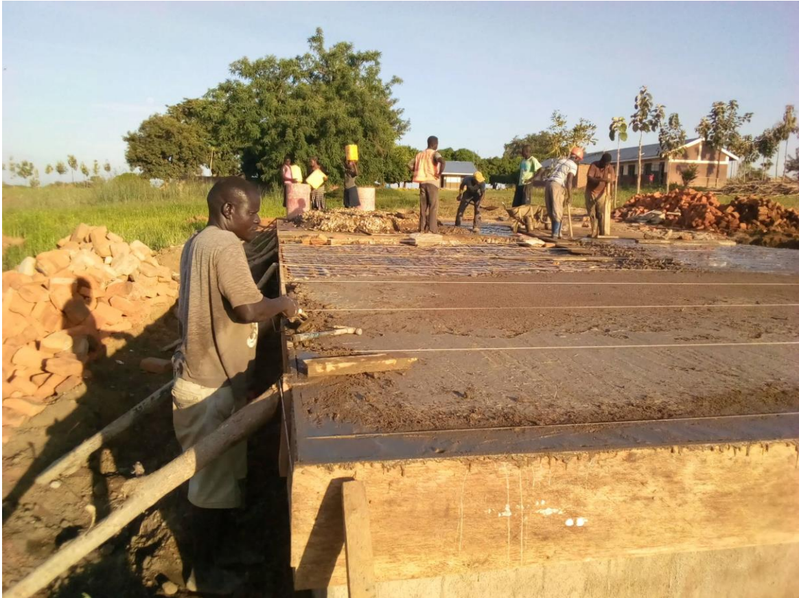
8.Trabajos de subestructura.
