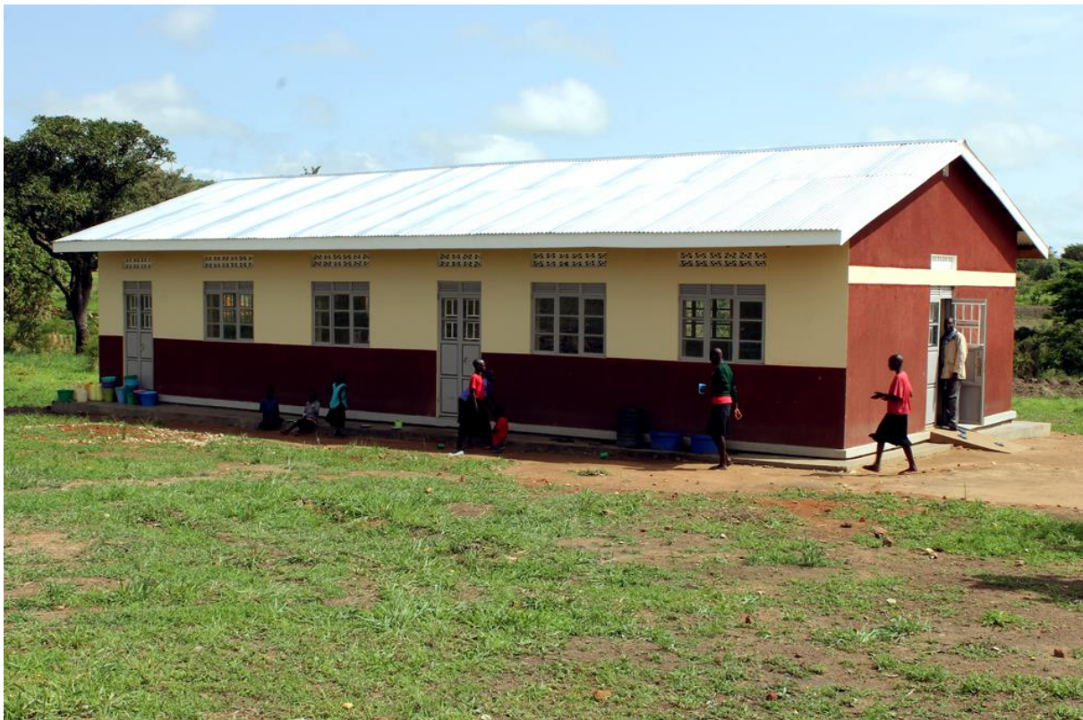
13. Exterior del edificio concluido.
