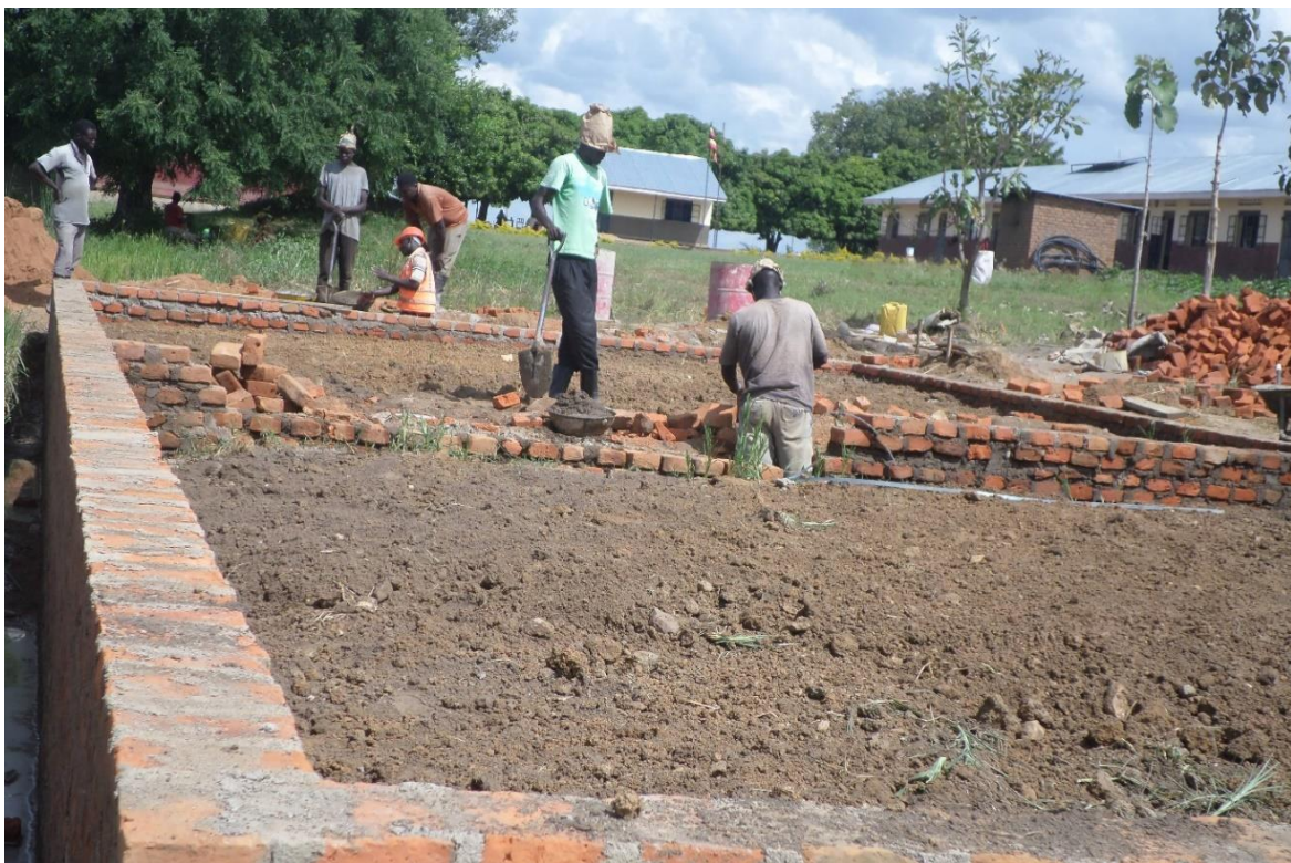
9.Trabajos de inicio de la superestructura.
