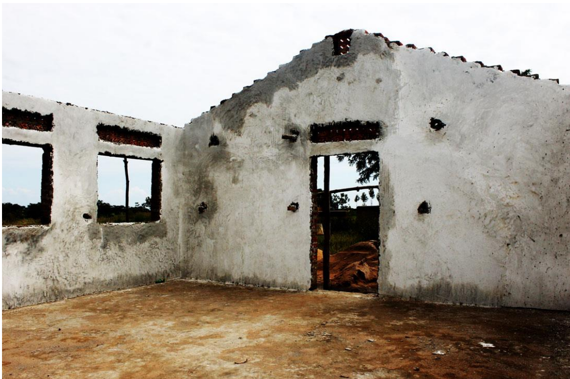
11. Superestructura desde el interior del edificio.
