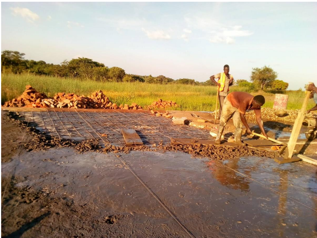
7. Trabajadores alisando la superficie de la subestructura.
