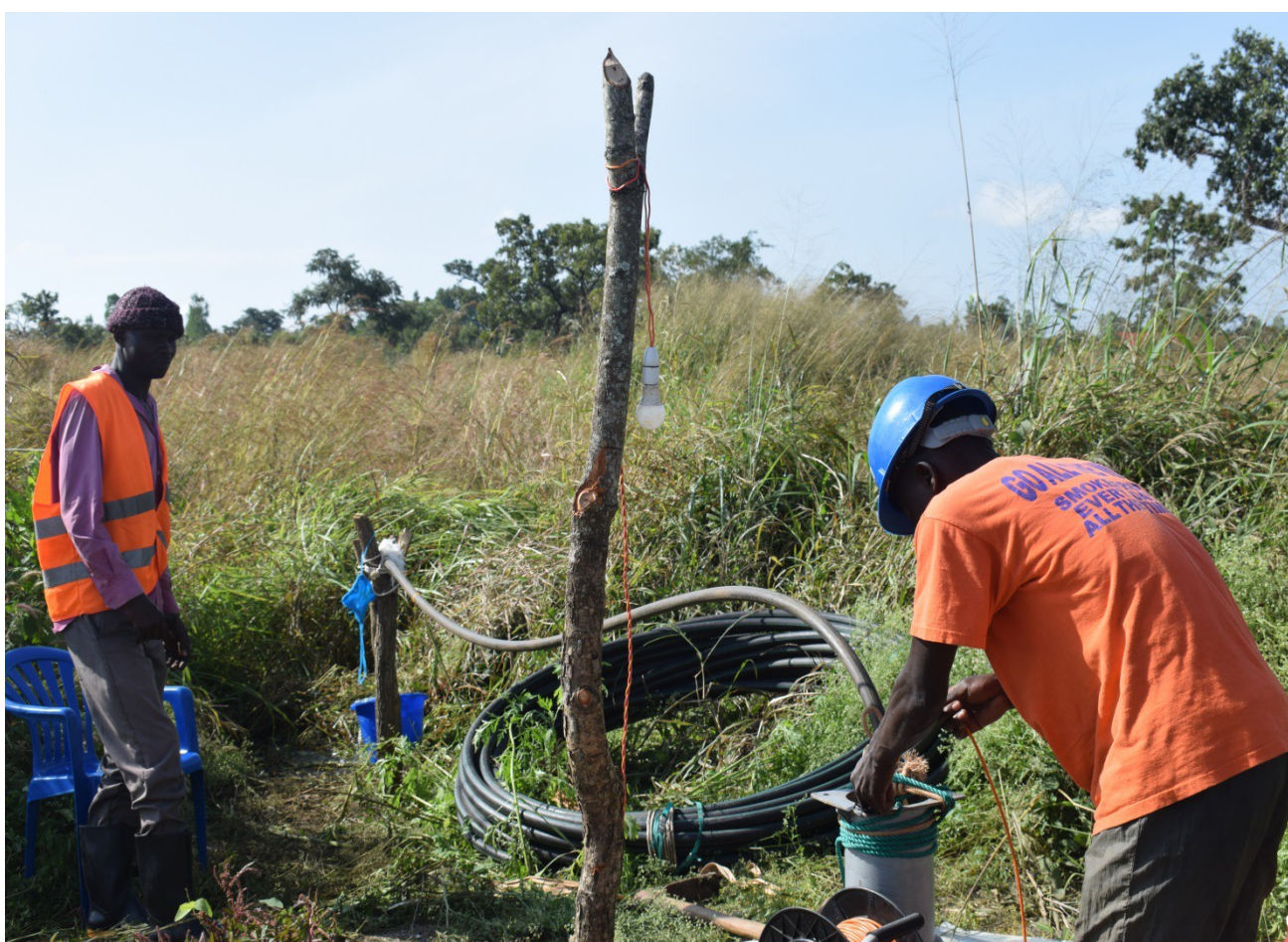
2. Operarios realizando Test de bombeo y potencia
