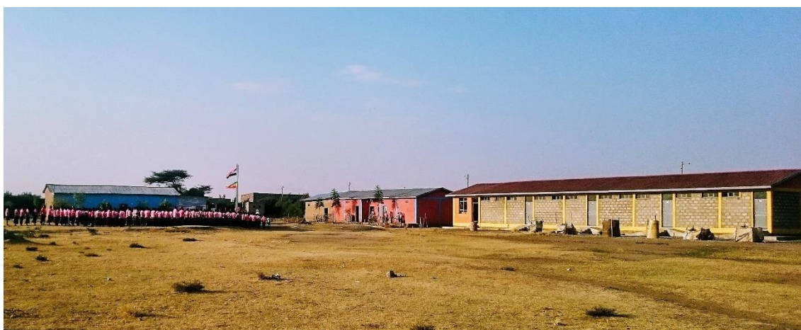
Renovación y equipamiento 4 aulas, construcción y equipamiento 4 aulas nuevas e instalación agua potable.
